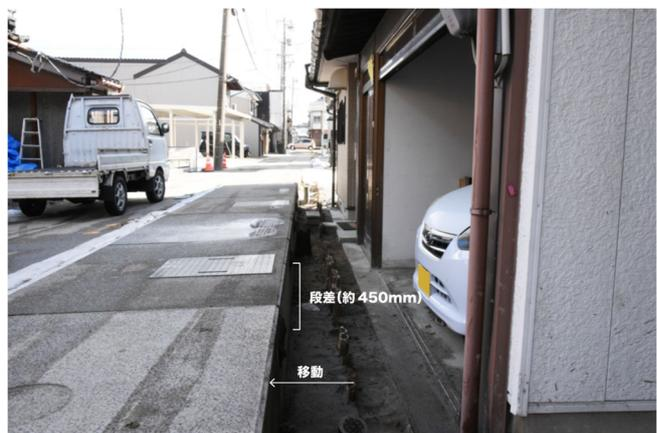
写真1 高岡市吉久の液状化による被害が特に大きい場所
