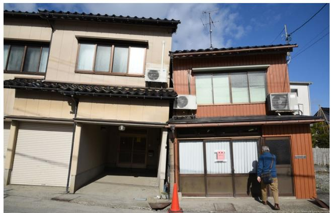
写真3 高岡市伏木の液状化によって傾いた建物
