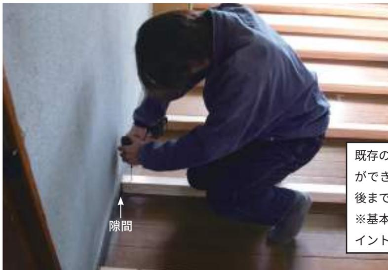
既存の床材と根太の間に隙間ができないように、ビスを最後まで打ち込む。
