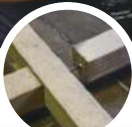
十字の部分はビスをダボの様に利用して施工した。8mmドリルビットで50mm程度穴をあけ、飛び出させておいたビスを穴に差し込み、ボンドで固定する。
