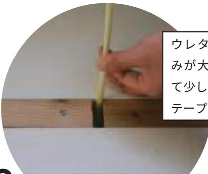
キッチンの部分は断熱材を設置してから根太を打ち付けた。
