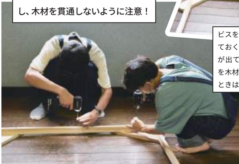
ビスを打つ位置に鉛筆などで印をつけておく。メジャーの端から測ると誤差が出てしまうため、100mmのメモリを木材の端に充てて測るといい！測るときはなるべく基準を一カ所にする。
