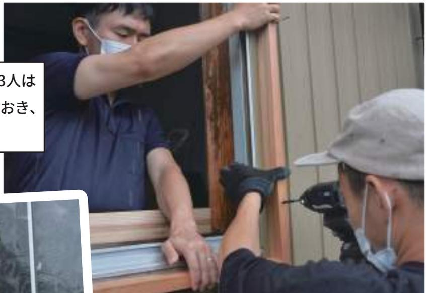
枠の対角を測ることで直角を出すことができる。適宜、水平器も使用して垂直水平を確かめながらビスを打っていく。
