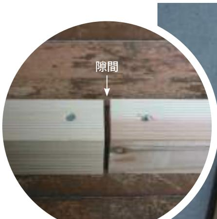
壁との間や根太と根太の間に3mm程の隙間を作ると床なり防止になる。
