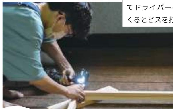
木材がずれないように、木材を上からしっかり押さえつけてビスを打つ。木材同士が引っ張り合うように、ビスは木材に1ミリ程度陥没させる。※直角クランプを使用すると角を固定しやすい。
